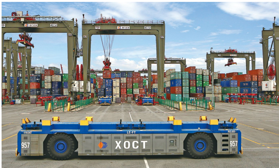
厦门远海码头 5G 全场景应用智慧港口
