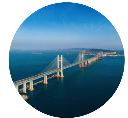
● 平潭海峡公铁两用大桥
