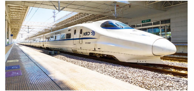
福厦高铁晋江动车站
